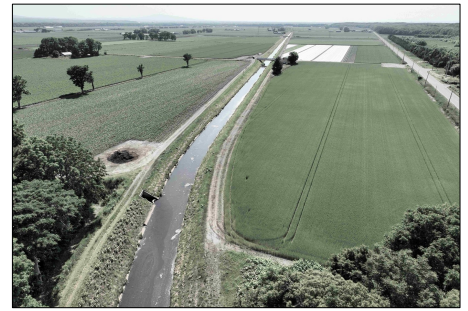
市街地から西4線(手前)への飽寒別排水路
