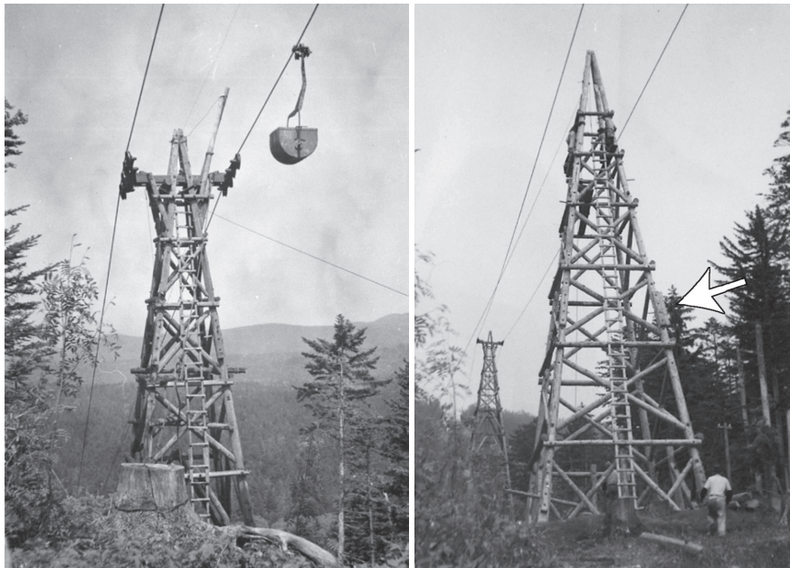
図22. 阿寒硫黄鉱山の索道支柱 左: 索道の支柱(1954年野中 信郎撮影, 石川2015から引用), 右: 索道の設置工事(1952年野中 信郎撮影, 石川2015から引用)。人物の身長を約170 cmと仮定すると、柱の高さはおおよそ12 mになる。柱の中間部分で2本の木材がつなぎ合わされているのがわかる(矢印部)。
