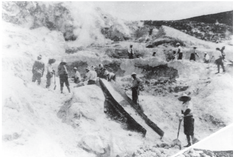
図16.4. 1号火口内部の採掘の様子(日本特殊鉱業撮影)。長径50m弱×短径45m程度の小さなスペースに17人もの労働者が人海戦術で採掘している様子が見られる。
