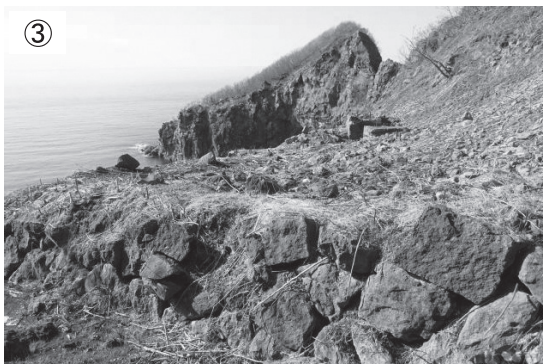
図4. 第一鉄索下の駅のコンクリート構造物と石垣。玉砂利をまぜた堅固なコンクリートに鉄のボルトが埋め込まれている。また石垣によって沢の水流から造成地を保護していた様子がわかる。
