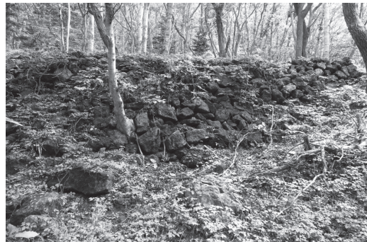
図7.5. 標高320 m付近にある造成地の石垣。自然石を利用した野面積み。
