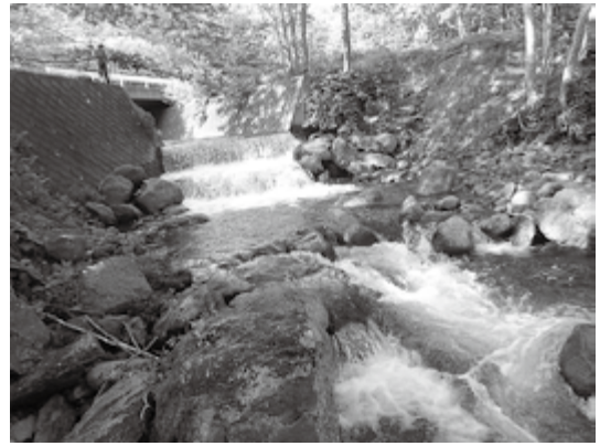
図32. 盤の川橋梁の下流にある落差工, 2015年5月30日撮影.
