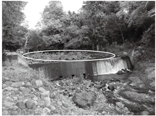
図4. 谷止工にたまった砂(満砂), 2011年10月13日撮影.
