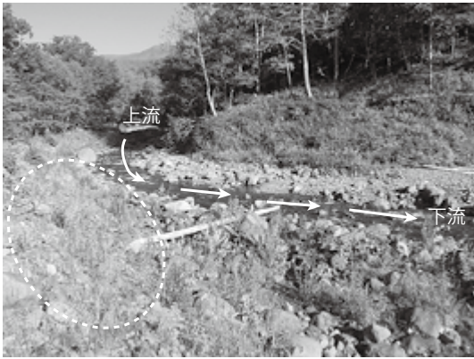
図22. 土手切り崩し前の工区6. 2013年10月4日撮影.
