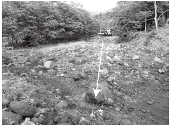
図24. 土手切り崩し後の工区6. 2014年7月16日撮影.
