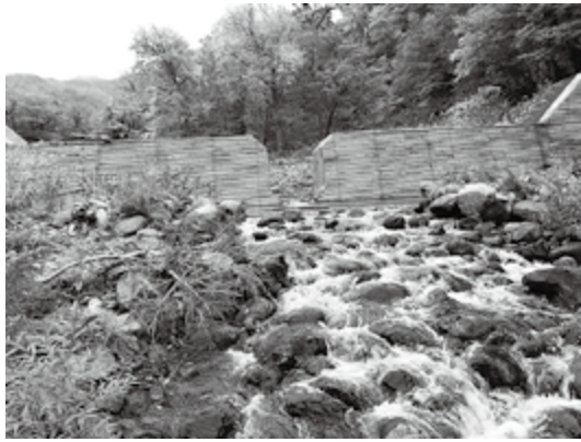
図31. ピリカベツ川谷止工につけられたスリット, 2014年10月6日撮影.
