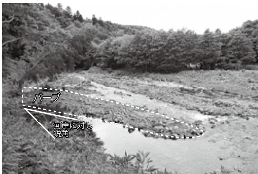
図18. バーク設置直後の様子。2013年7月23日撮影。
