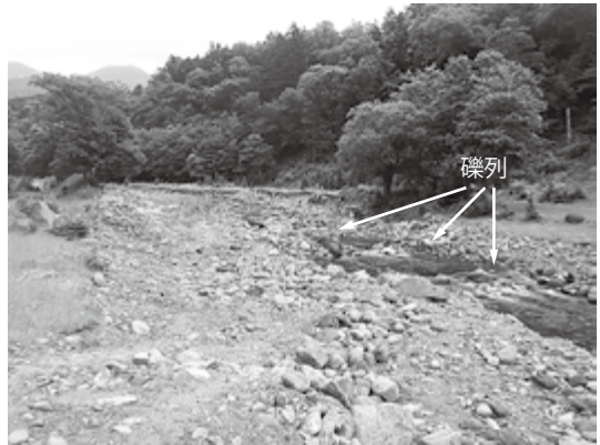
図9. 人工的に礫列を設置した直後. 2012年7月25日撮影.
