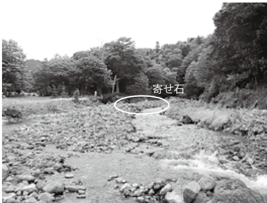
図13. 右岸河岸の侵食を防止する寄せ石, 2013年7月23日撮影。
