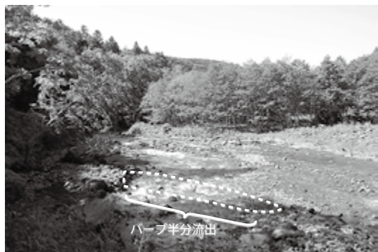
図19. バークの半壊した状況。2013年10月4日撮影。
