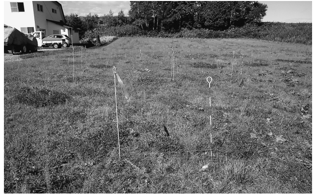
トレンチ1・2 掘削前状況
